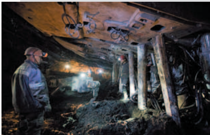
Демонтаж секции крепи шахты «Комсомолец»
