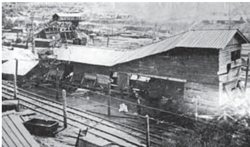
Первая пломплощадка главного ствола шахты «Капитальная», 30-е годы
